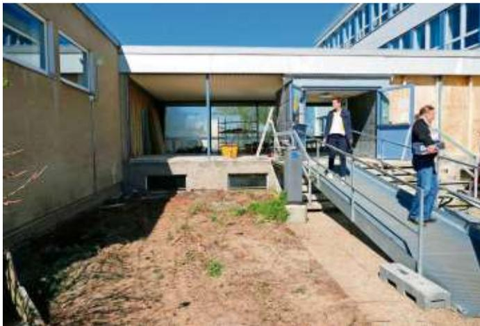
Die großen Fensterfronten in der Aula werden nach und nach ausgebaut, verkleinert und neue energetische Fenster zum Öffnen und mit Sonnenschutz eingebaut.
