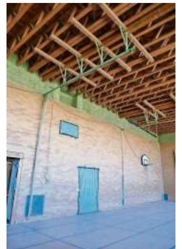
In der Turnhalle ist die Decke bereits demontiert. Hier wird eine Deckenstrahlheizung mit integrierter Beleuchtung und Lautsprechern installiert und im Anschluss eine Paneelen-Decke montiert.
