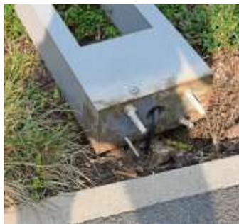
Samt Schrauben und Dübeln aus der Verankerung gerissen – eine der Gehwegbeleuchtungen am Freibadparkplatz.
